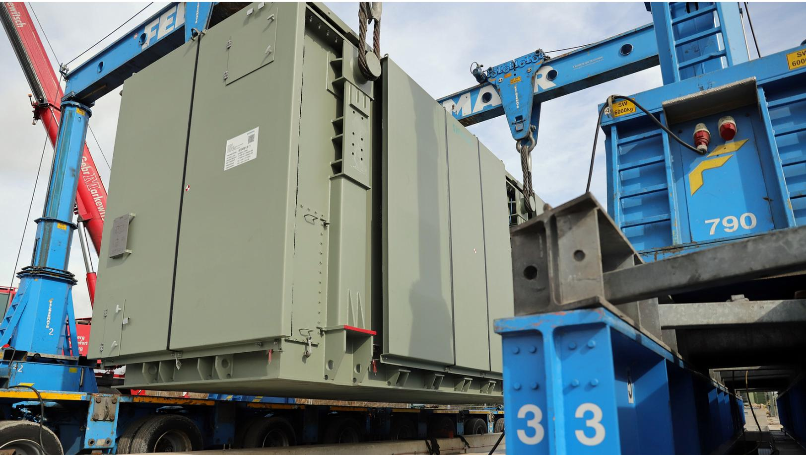
Eine Spule in dieser Größe hat die Bayernwerk Netz GmbH nun in Pleinting in Betrieb genommen. Der Technik-Koloss kompensiert unerwünschte Blindleistung im Netz.
