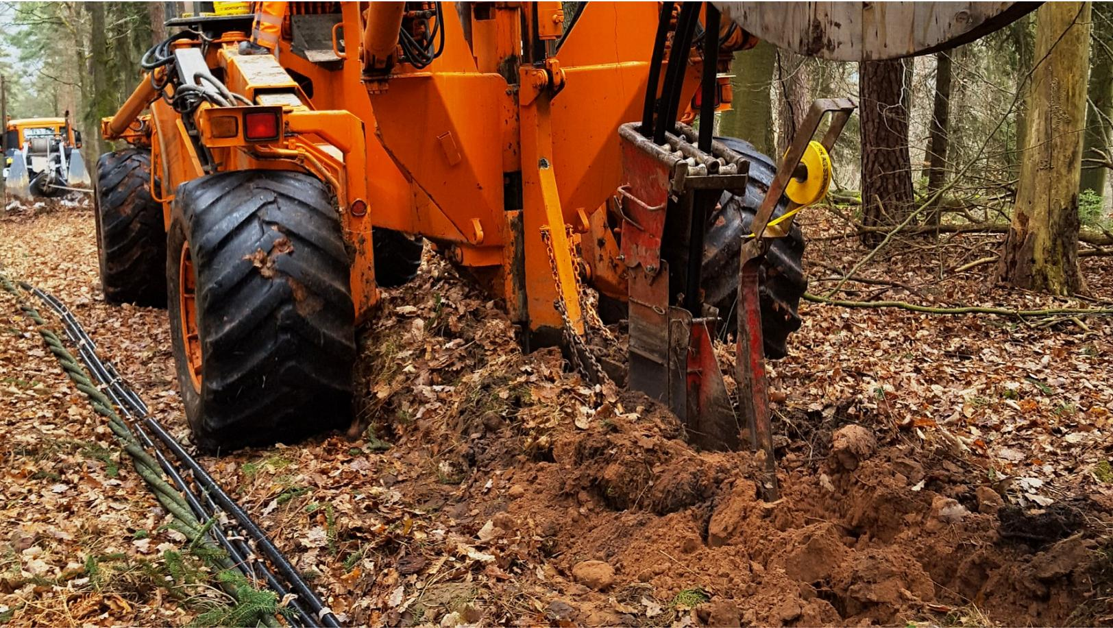
Das neue Stromkabel zwischen Rüdenuau und Mainbullau ist über weite Strecken mit einem Pflug schonend unter die Erde gebracht worden.
