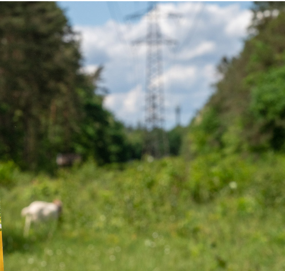
Lebensräume unter der Hochspannungsleitung
