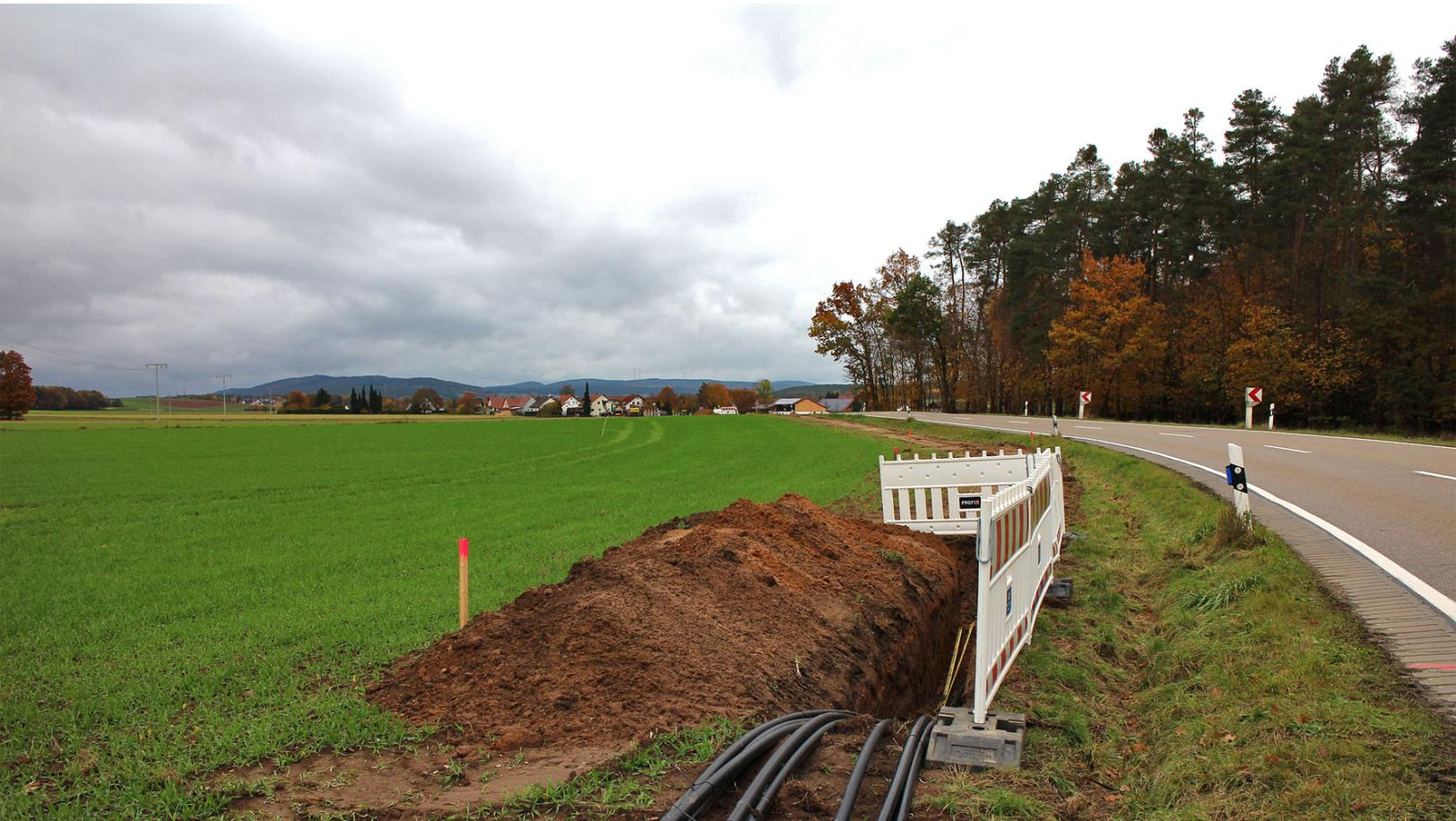
Die Bayernwerk Netz GmbH verlegt entlang der Staatsstraße St 2156, hier bei Grafenricht, leistungsstarke Mittelspannungskabel. Die Maßnahme ist Teil eines großen Netzbauprojektes zwischen dem Schalthaus Buchtal und dem Umspannwerk Schwarzenfeld.
