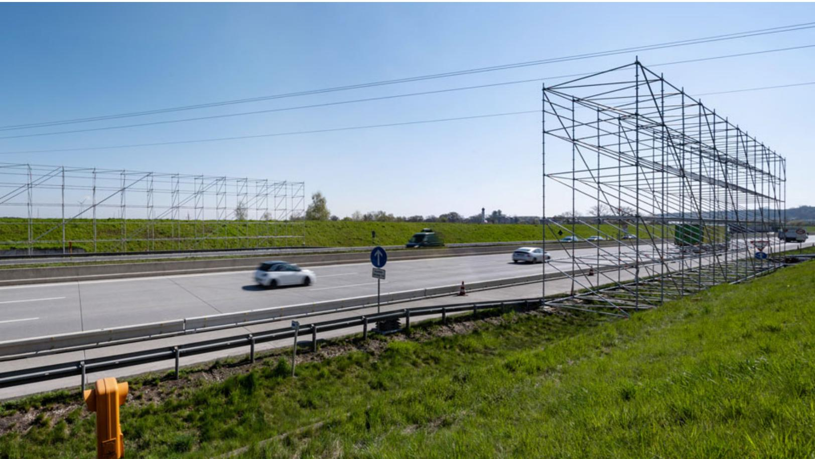
Neben der Autobahn bei Sulzemoos baut die Bayernwerk Netz Gerüste auf. Ein Netz über der A8 soll während der anstehenden Sanierung der Hochspannungsleitung die Autofahrer schützen.
