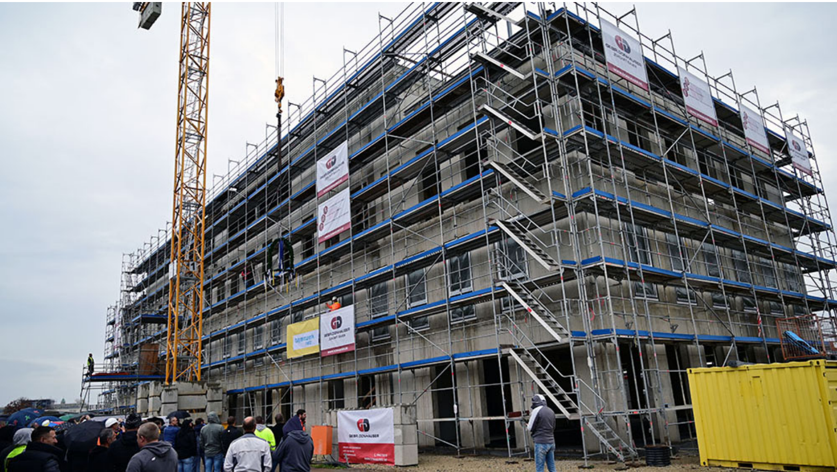
Richtfest des Bayernwerk-Neubaus in Bamberg
