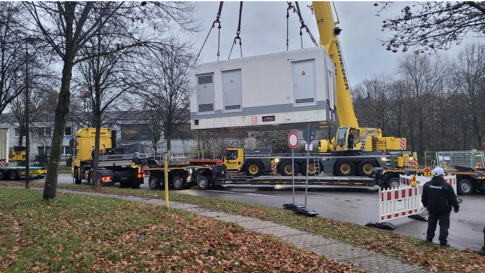
In den Morgenstunden hat eine Spedition die neue Schaltanlage der Bayernwerk Netz nach Oberthann geliefert. Ein Autokran hat das Fertigteil-Gebäude auf das vorbereitete Fundament gehoben.
