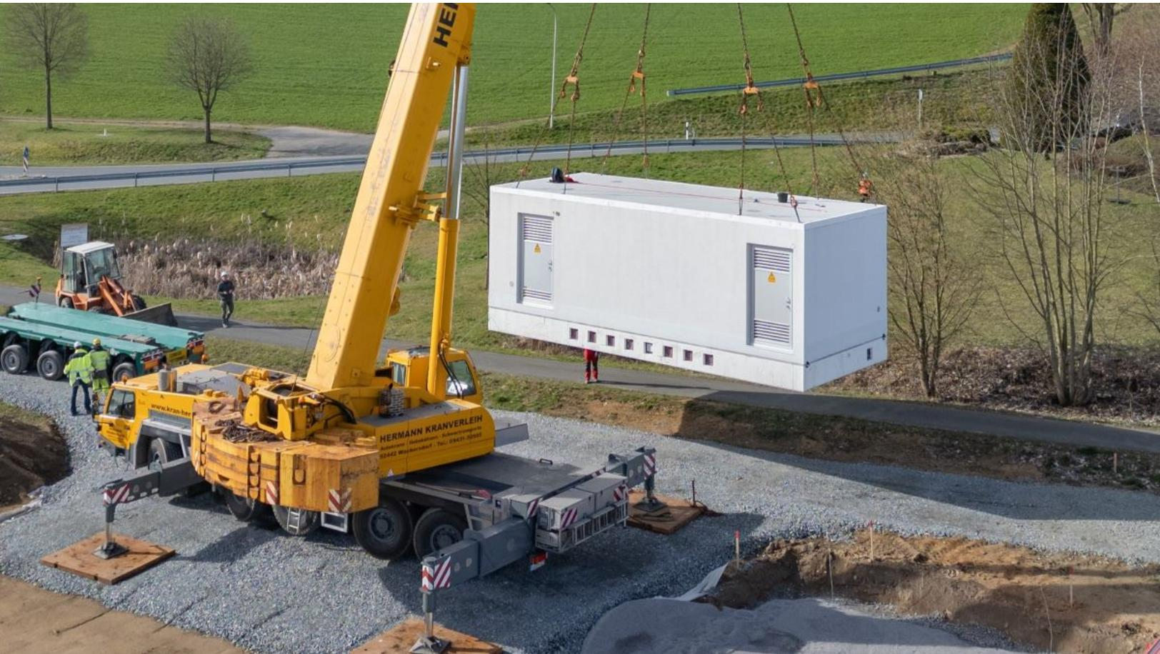
Die neue Schaltstation wurde als Betonfertigteil mit einem Schwerlasttransporter in den Floßer Ortsteil Gailertsreuth angeliefert.
