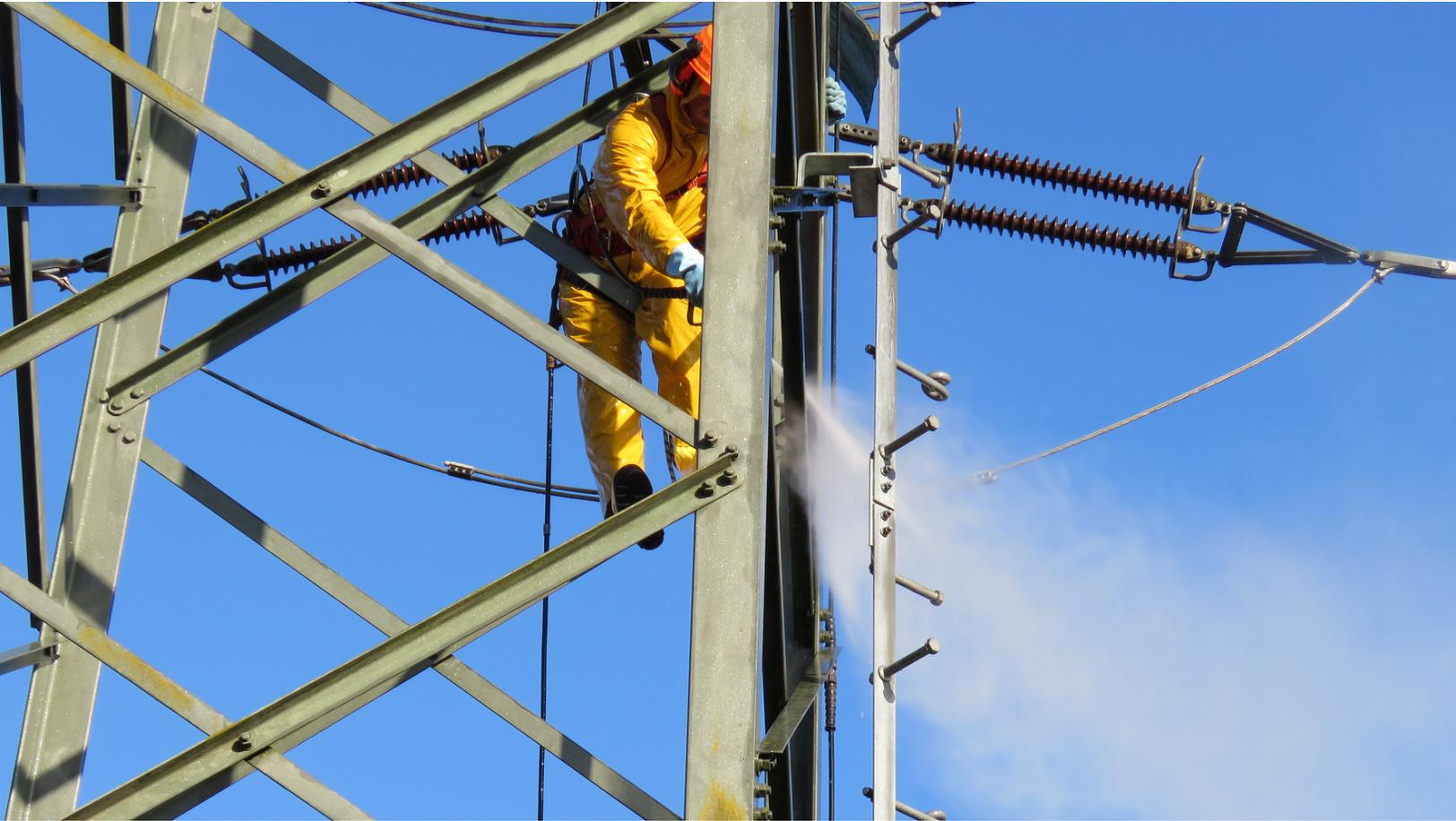
Die Bayernwerk Netz GmbH erneuert bis voraussichtlich Anfang Oktober 2025 den Korrosionsschutz von 51 Masten der Hochspannungsfreileitung zwischen Amberg und Sulzbach-Rosenberg.
