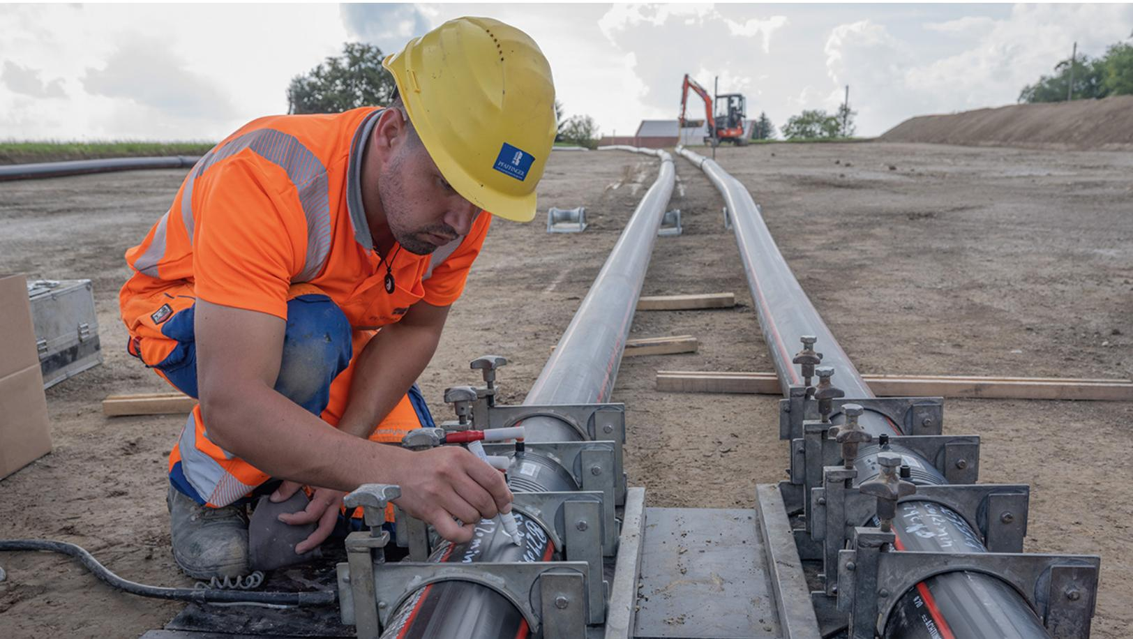
Für den Anschluss Bachel liegt der Bayernwerk Netz nun die Genehmigung zum Bau vor. Die 110-kV-Kabel werden in Leerrohre - wie hier auf einer anderen Baustelle in Niederbayern - eingezogen.
