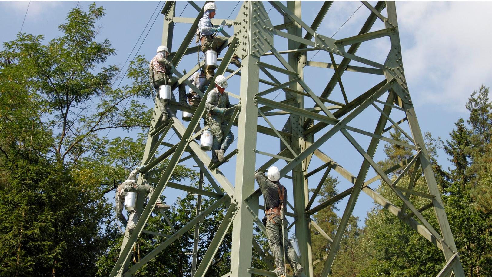
Die Bayernwerk Netz GmbH erneuert bis voraussichtlich Ende September 2025 den Korrosionsschutz von 73 Masten der Hochspannungsfreileitung zwischen Trennfeld im Landkreis Main-Spessart und Würzburg. (Foto: Bayernwerk Netz GmbH)
