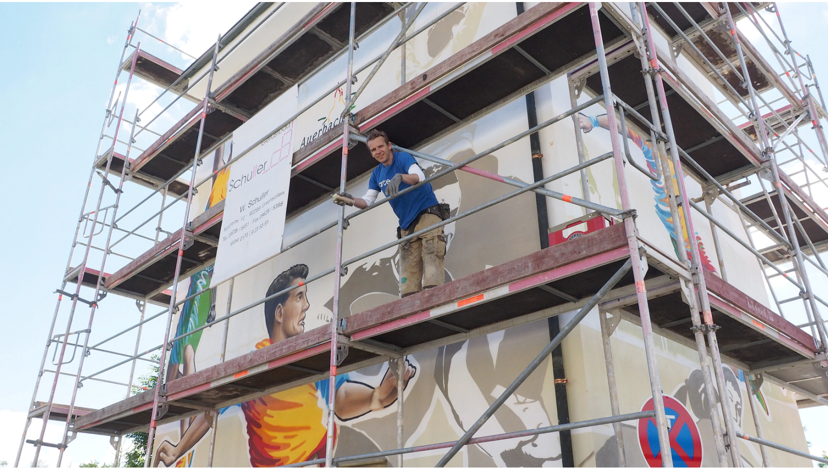
Trafostation des Bayernwerks wird künstlerisch umgestaltet
