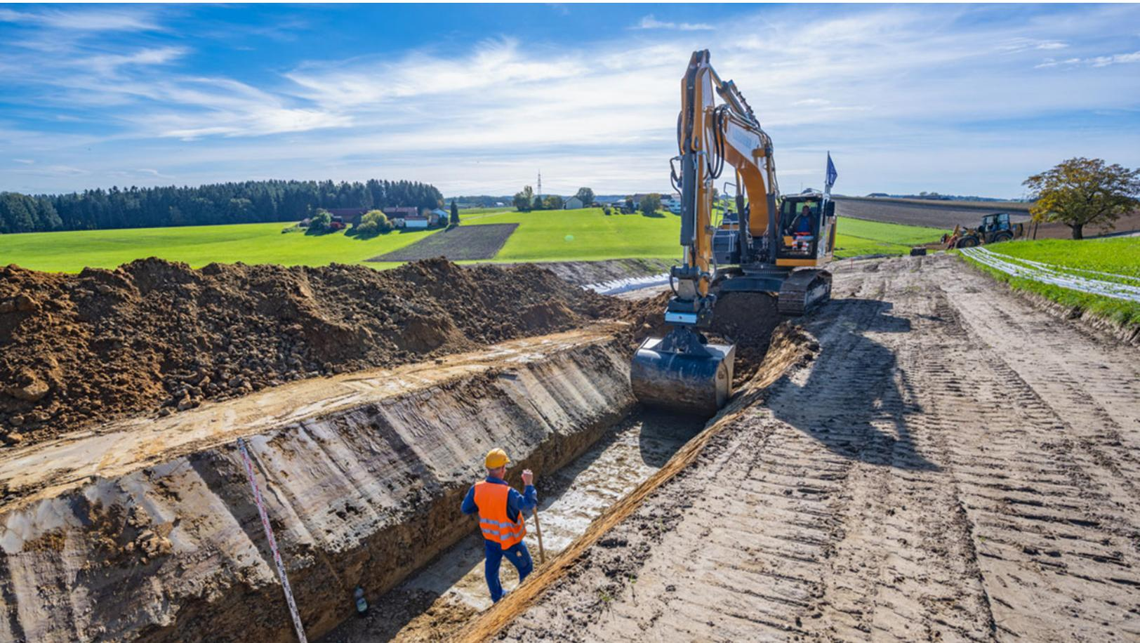
Für das neue Hochspannungserdkabel wird ein etwa 1,75 Meter tiefer Graben ausgehoben, wie kürzlich bei einer ähnlichen Baustelle der Bayernwerk Netz in Niederbayern.
