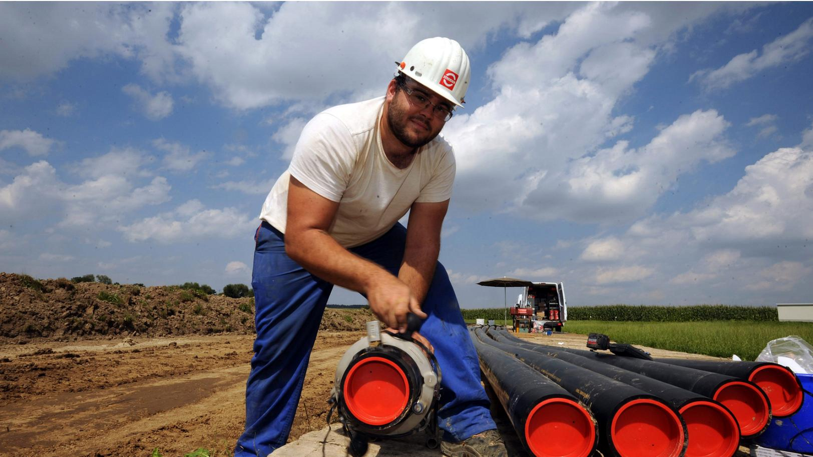
Die Bayernwerk Netz plant den Bau einer neuen 110kV-Kabelstrecke in Fürth. Wie zuletzt in Oberbayern (Bild) werden zunächst Leerrohre verschweißt und verlegt, um die Kabel später einzuziehen.
