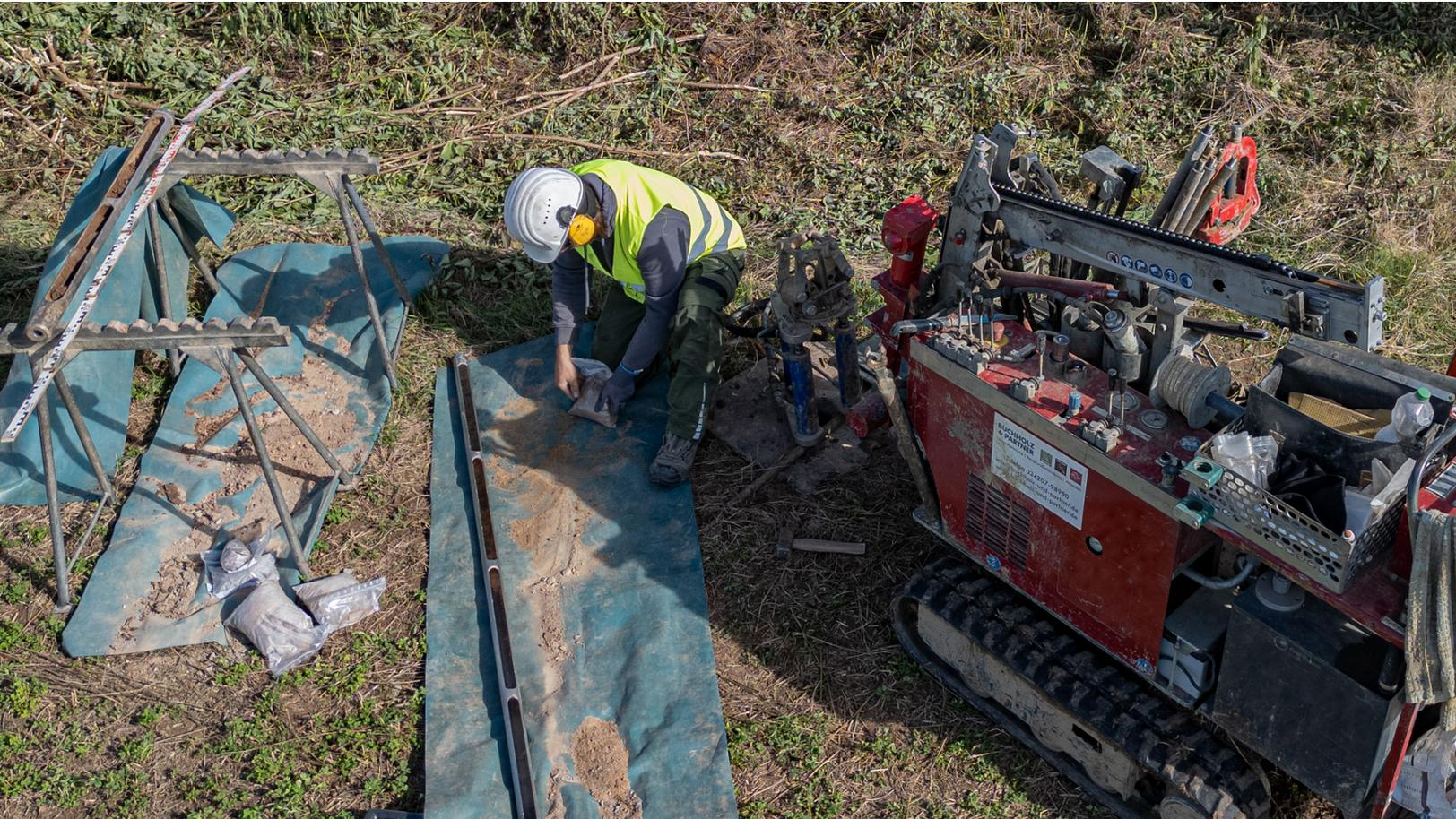
Entlang der Leitung zwischen Bergtheim und Bergtheinfeld lässt die Bayernwerk Netz den Baugrund untersuchen. Die Tests geben Aufschluss über die Tragfähigkeit und die Beschaffenheit des Bodens und potenzielle Risiken.
