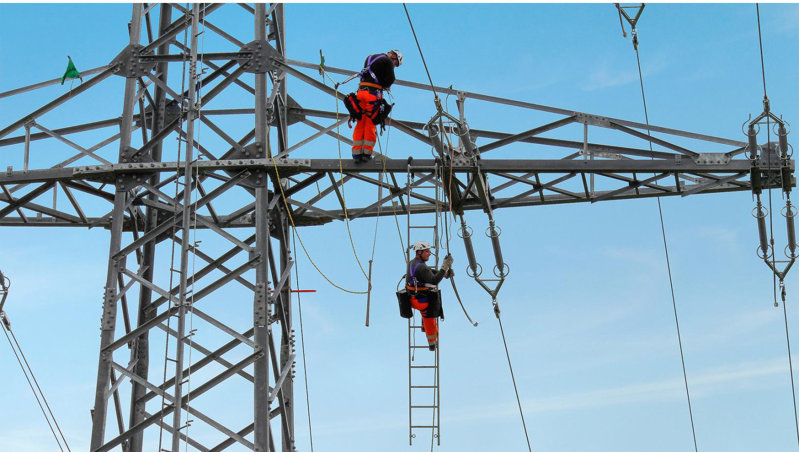
Monteure erneuern eine Hochspannungsleitung der Bayernwerk Netz. Zwischen Weiden und Schirmitz stehen zunächst Vermessungen zur Vorbereitung eines Ersatzneubaus an.
