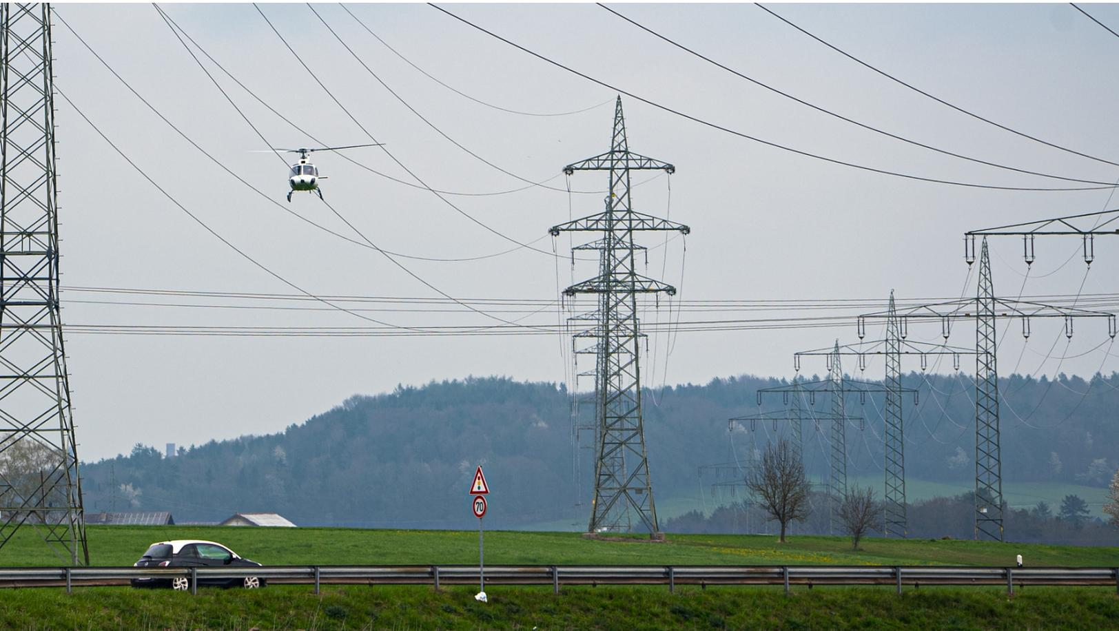
Der Heli schwebt nah an die Hochspannungsleitung heran, damit die Techniker des Bayernwerks die Masten und Seile genau unter die Lupe nehmen können.
