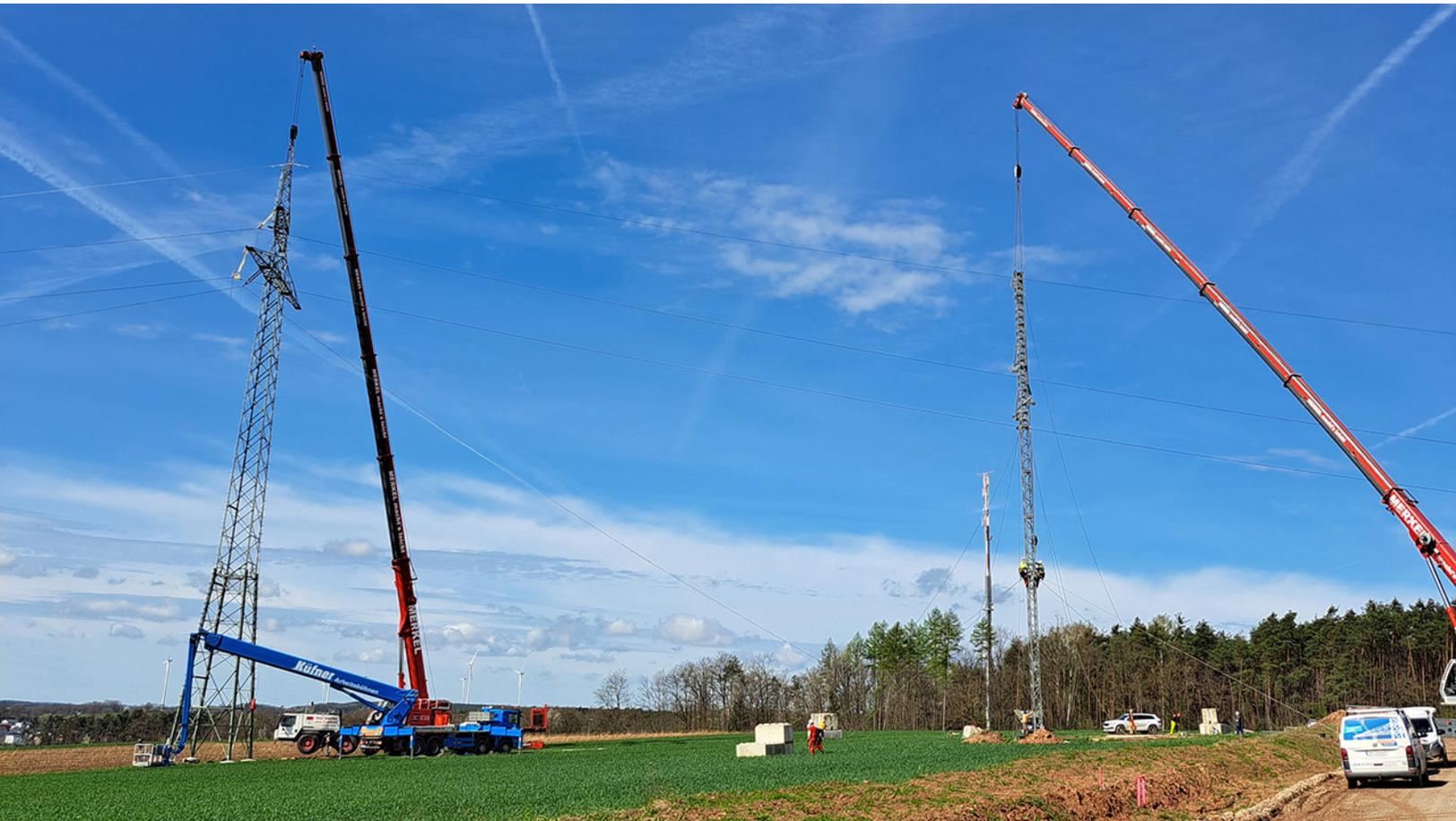
Bevor neue Stromleiterseile über die A3 gespannt werden können, sichert ein Kran den defekten Mast (links) und ein Kran ist beim Bau des Provisoriums im Einsatz.
