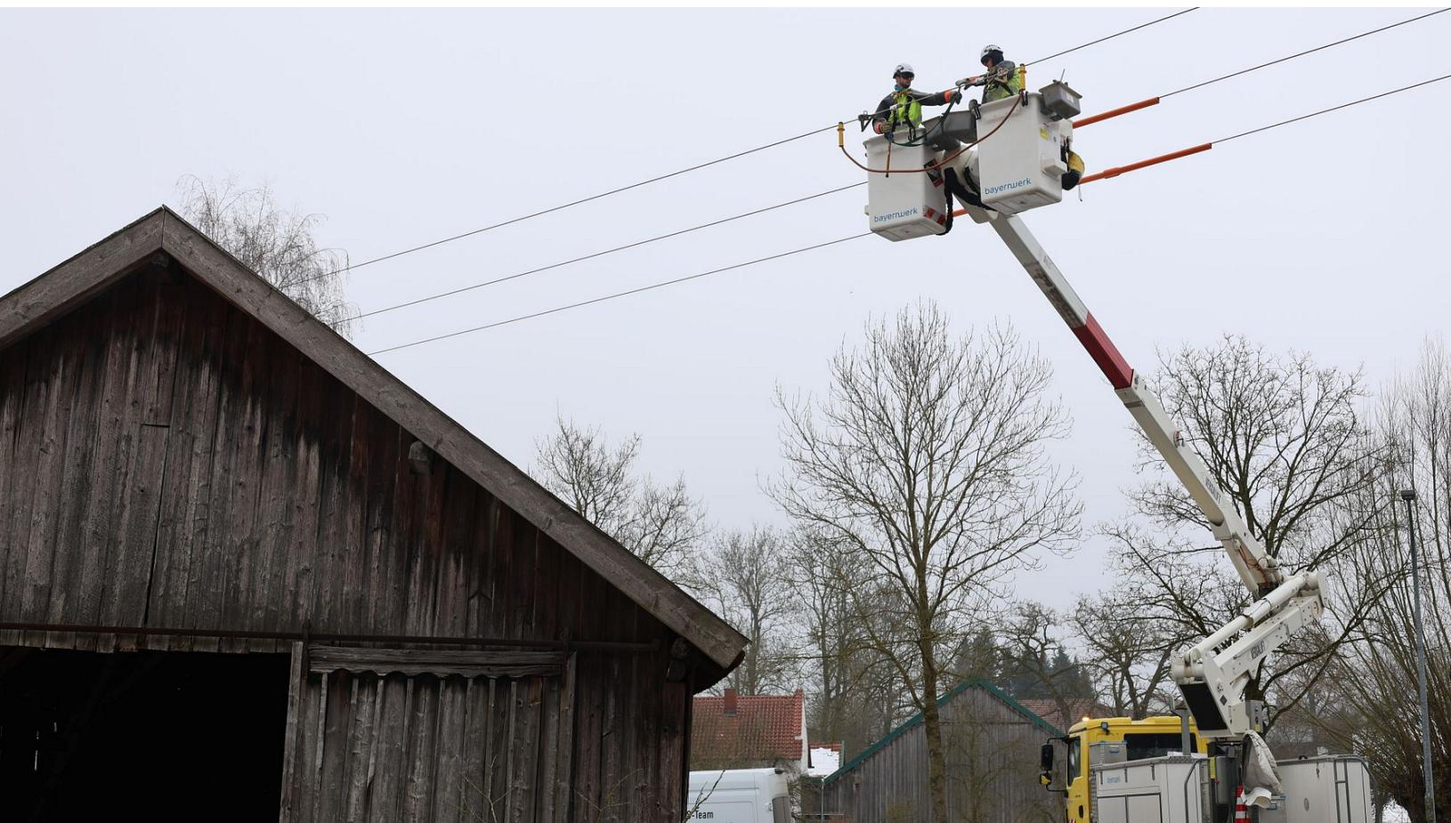
Arbeiten unter Spannung – Martin Peterlik und Sebastian Rothkopf bauen in einer 20.000-Volt-Freileitung eine flexible Trennstelle ein.
