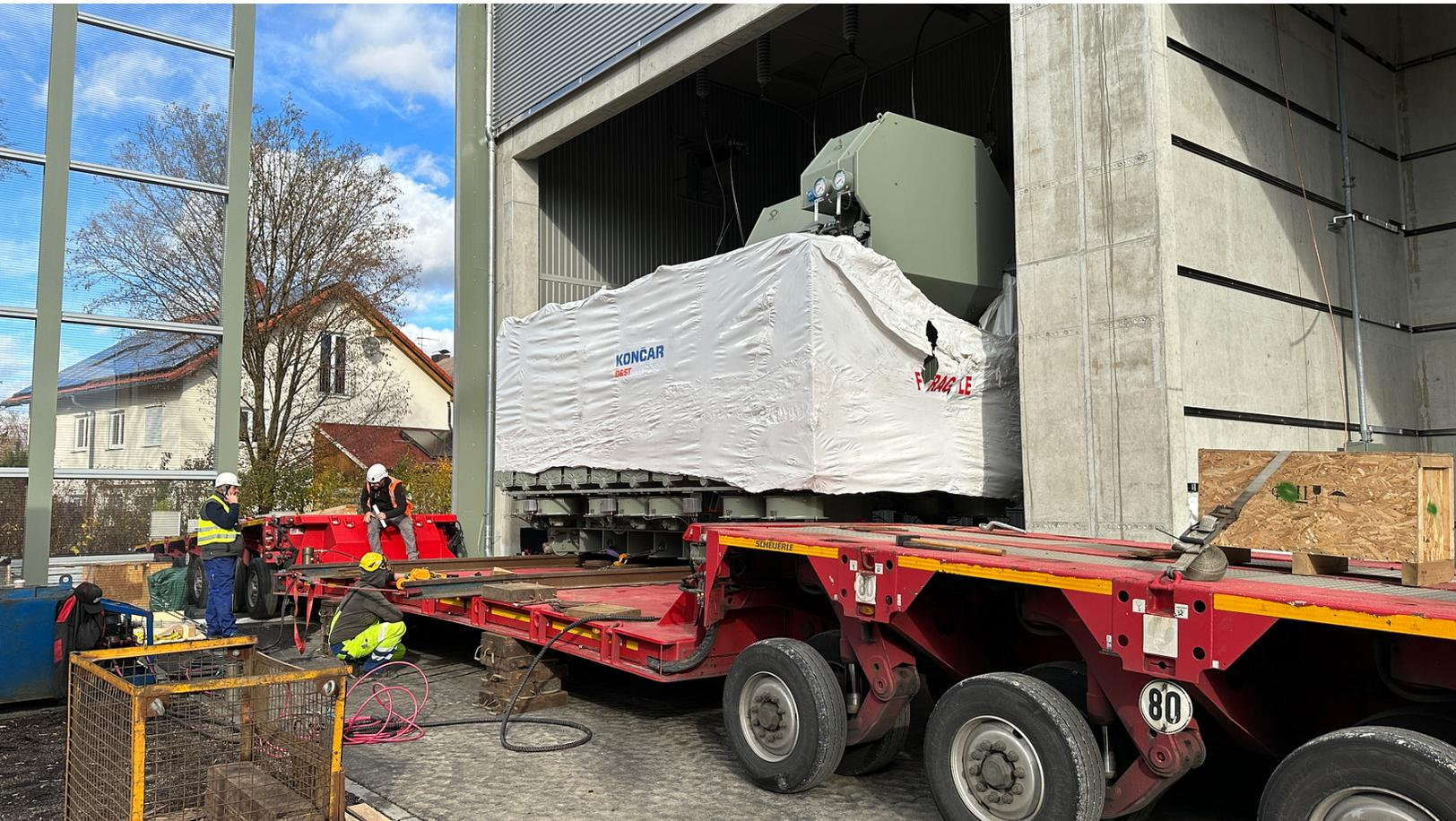
Mit Fingerspitzengefühl und voller Konzentration wird der 60-Tonnen-Trafo Zentimeter für Zentimeter vom Tieflader auf seinen neuen Platz im Umspannwerk Föhrenwald gezogen.
