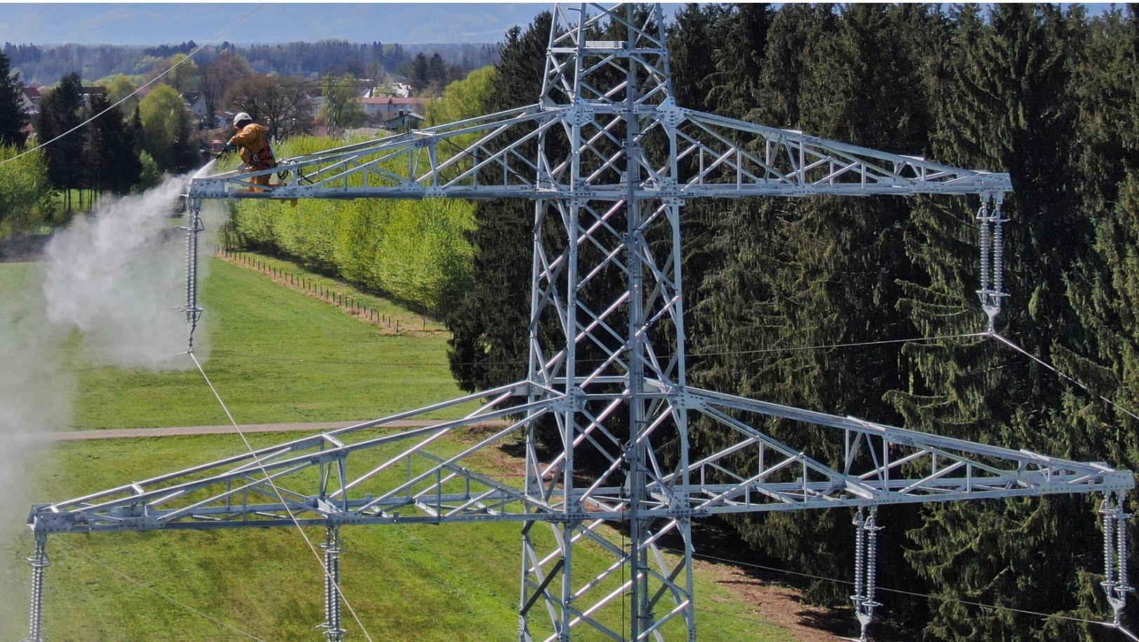
Die Bayernwerk Netz GmbH erneuert bis voraussichtlich 11. Juli 2025 den Korrosionsschutz von 57 Masten der Hochspannungsfreileitung zwischen Wasserburg am Inn und Mittergars.
