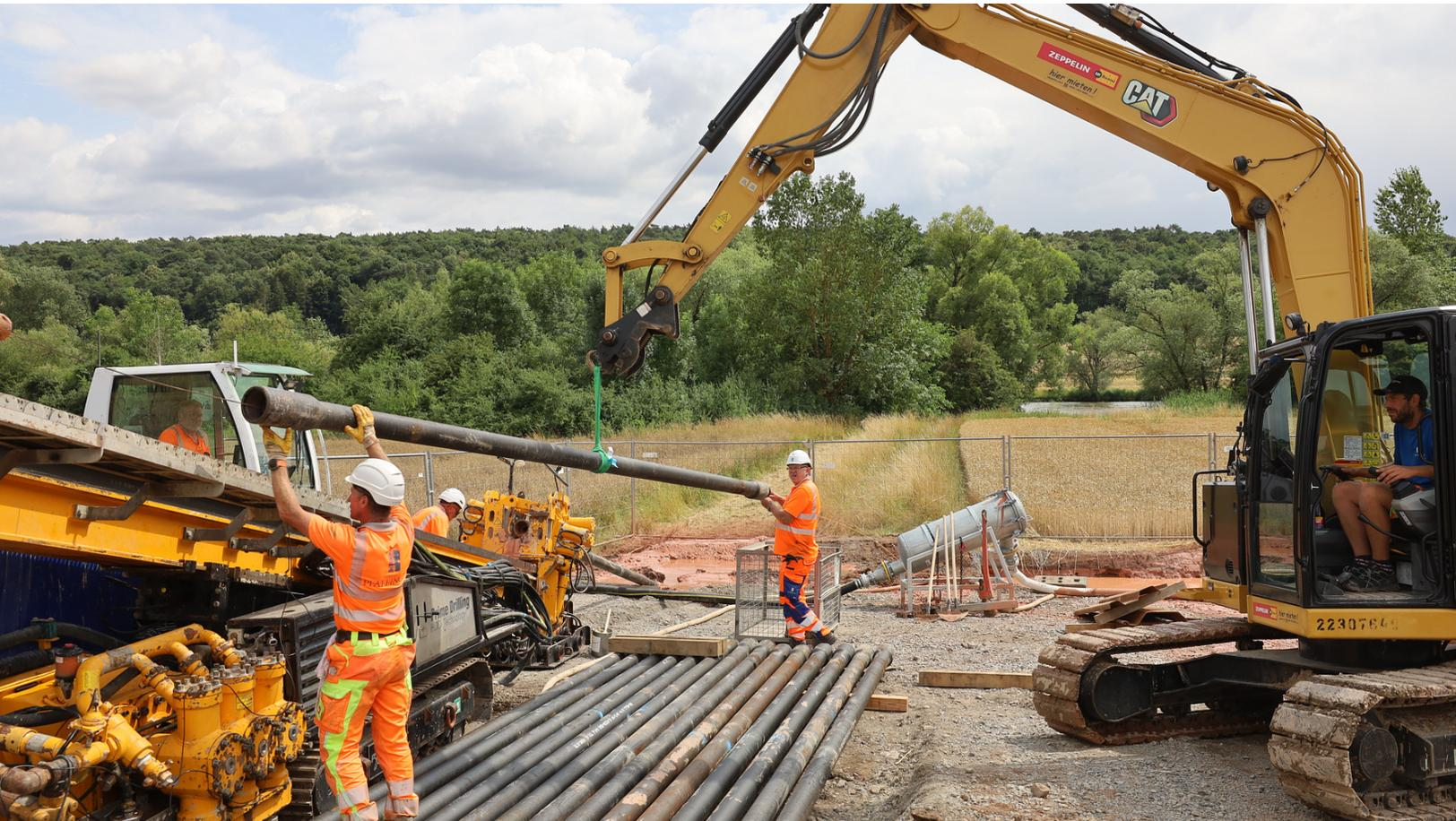
Neues Magazin für den Spülbohrer: Derzeit unterquert die Bayernwerk Netz im Auftrag der Stadtwerke Wertheim den Main für einen neuen Mittelspannungsanschluss.
