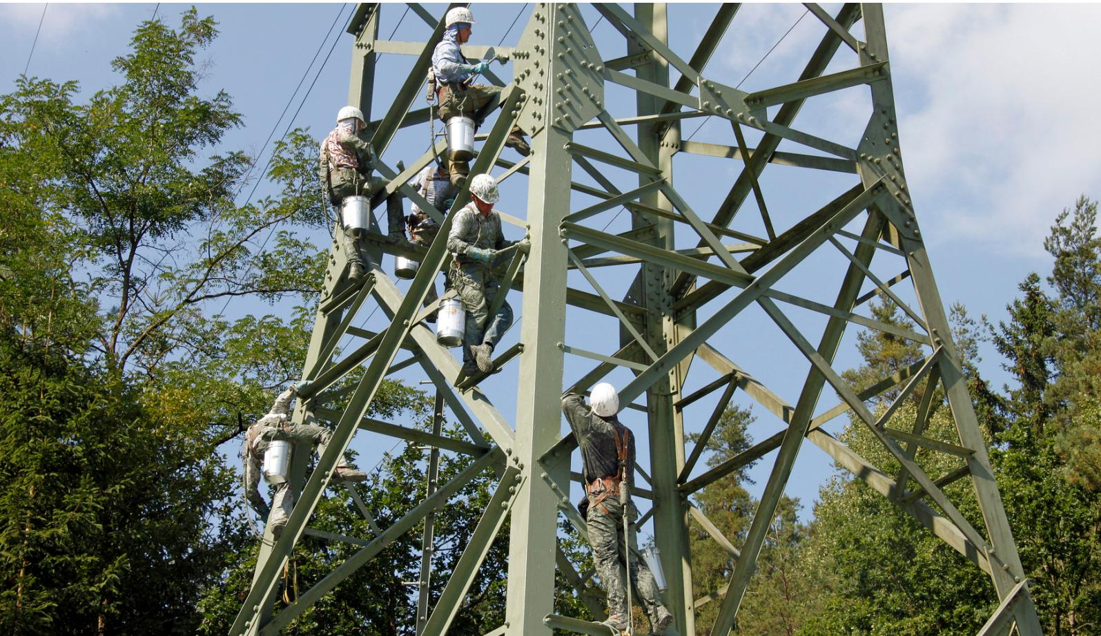
Echte Handarbeit: Mit dem Farbeimer am Gürtel und dem Pinsel in der Hand klettern Mitarbeiter einer Fachfirma im Auftrag des Bayernwerks auf Hochspannungsmasten. Der Anstrich erneuert den Korrosionsschutz.
