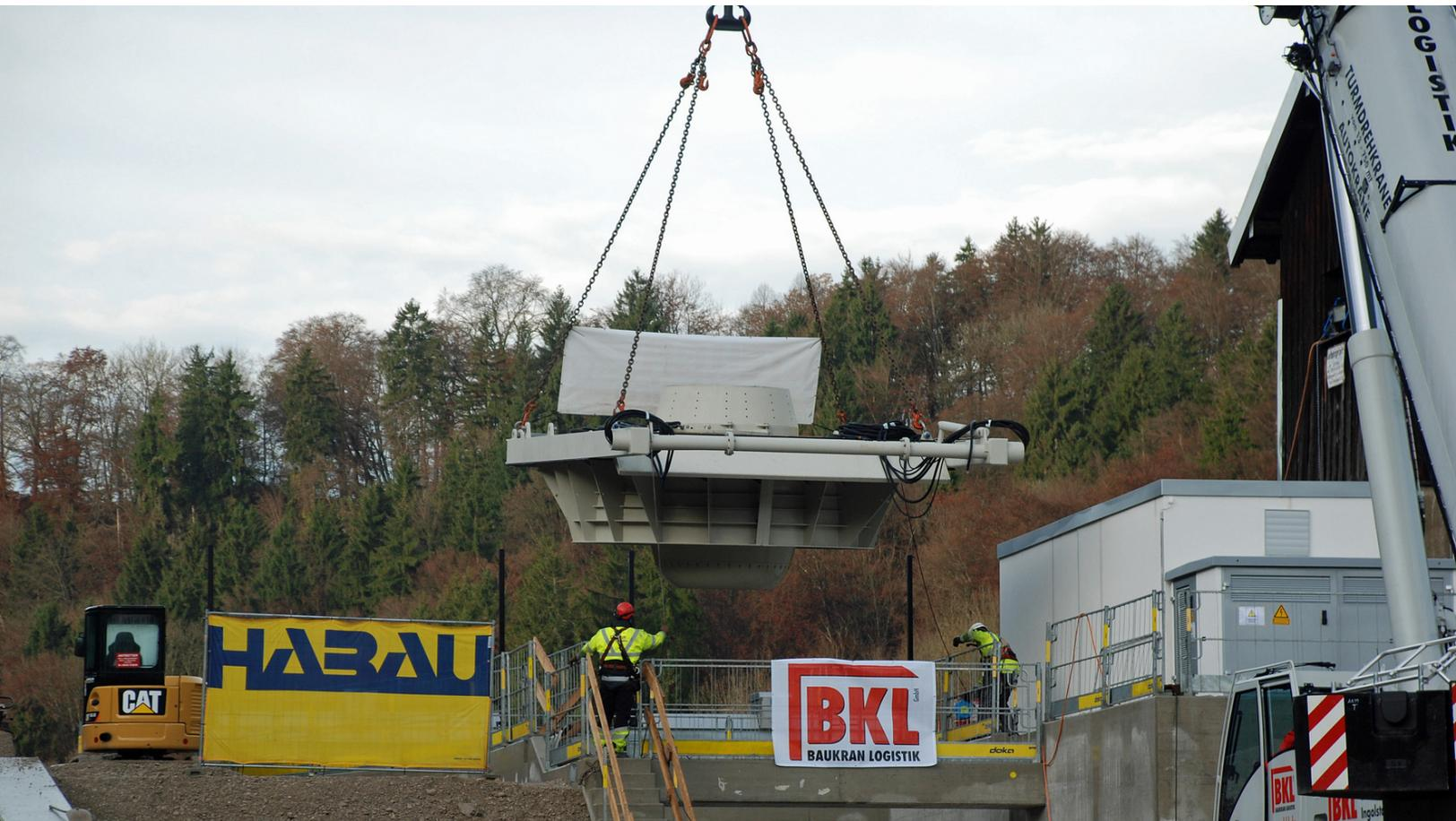
Am Haken eines Autokrans ist die neue Turbine des Wasserkraftwerks in Baierbrunn erfolgreich eingehoben worden.
